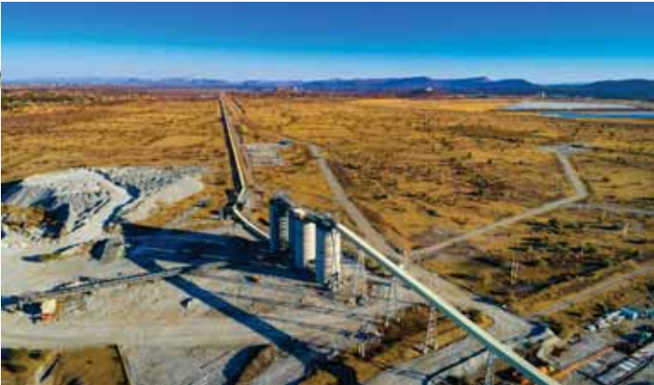
Styldrift surface silos
